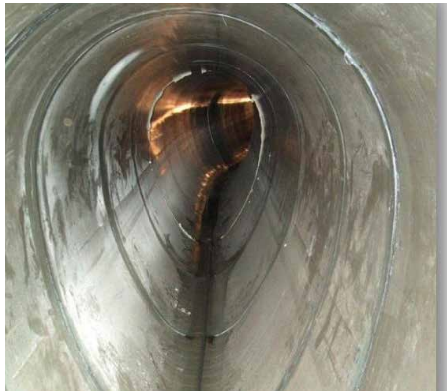
Рехабилитиран с яйцевиден GRP профил участък от канализационен колектор. Sewerage collector sector rehabilitated with egg-shaped GRP profile
